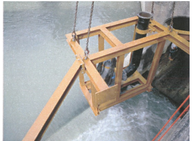
Foto 3 e 4: fasi di installazione pompa
