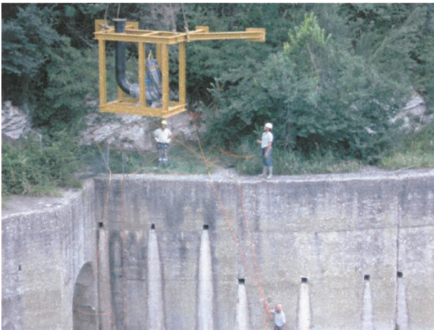
Foto 3 e 4: fasi di installazione pompa
