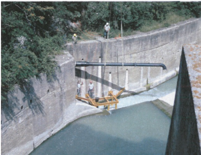
Foto 5 e 6: fasi di installazione tubazione collegamento con galleria di derivazione
