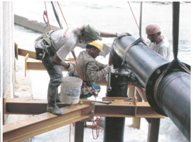
Foto 7 e 8: fasi di installazione tubazione in galleria e collegamento con pompa
