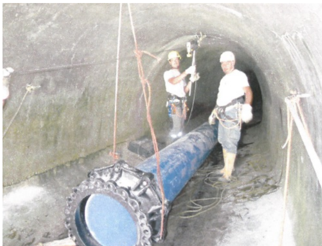
Foto 7 e 8: fasi di installazione tubazione in galleria e collegamento con pompa
