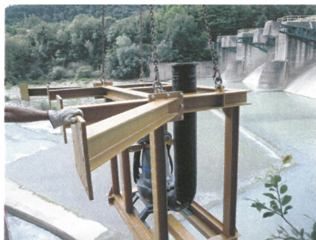
Foto 1 e 2: la struttura per il fissaggio della pompa
