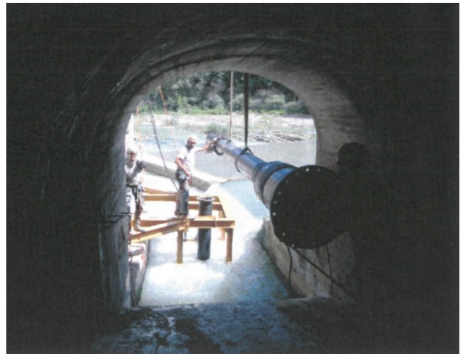
Foto 5 e 6: fasi di installazione tubazione collegamento con galleria di derivazione
